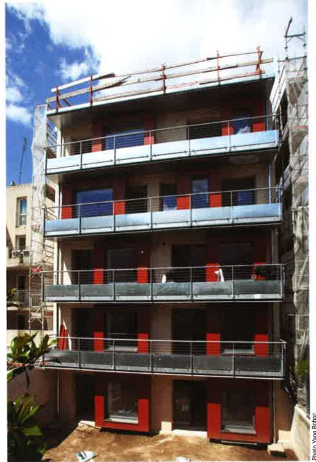
Façade sud équipée de bow-window.
